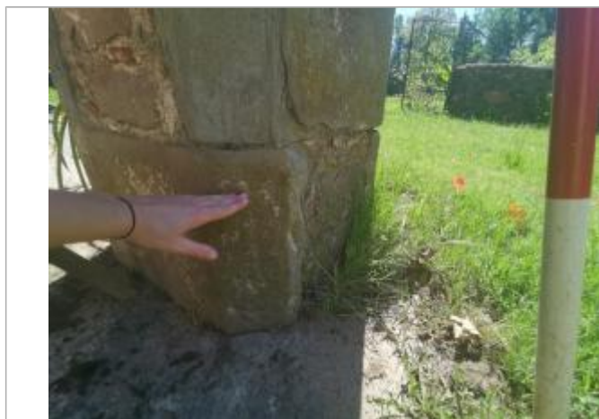
Poteau bâtiment moulin - Photo © AGERIN
