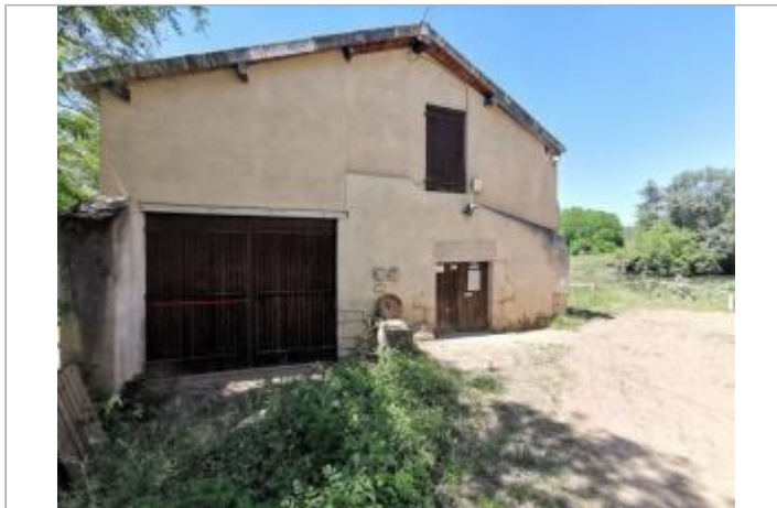
Porte bâtiment - Photo © AGERIN
