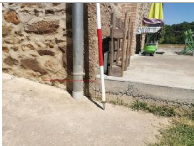
Gouttière maison moulin - Photo © AGERIN
