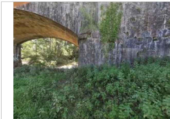
Pont (aval rive gauche) - Photo © AGERIN
