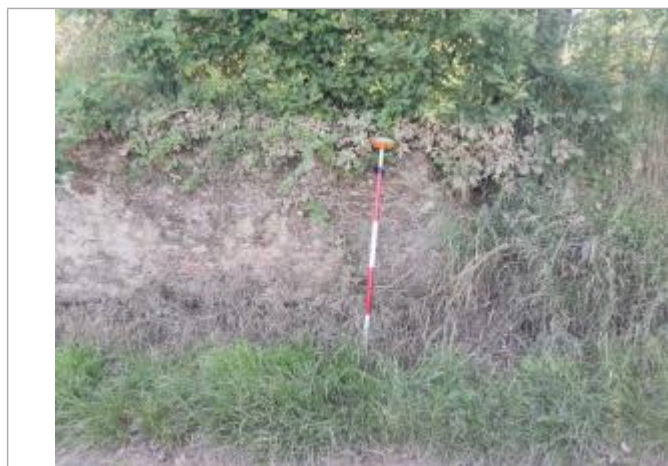
Trace de boue sur vegetation - Photo © AGERIN
