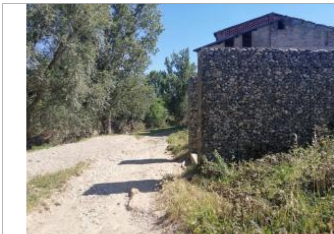
Mur en gabions - Photo © AGERIN
