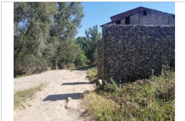
Mur en gabions - Photo © AGERIN
