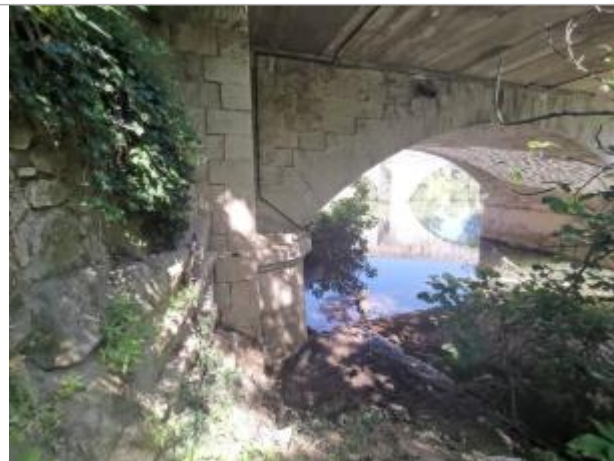
Pont (amont rive gauche) - Photo © AGERIN
