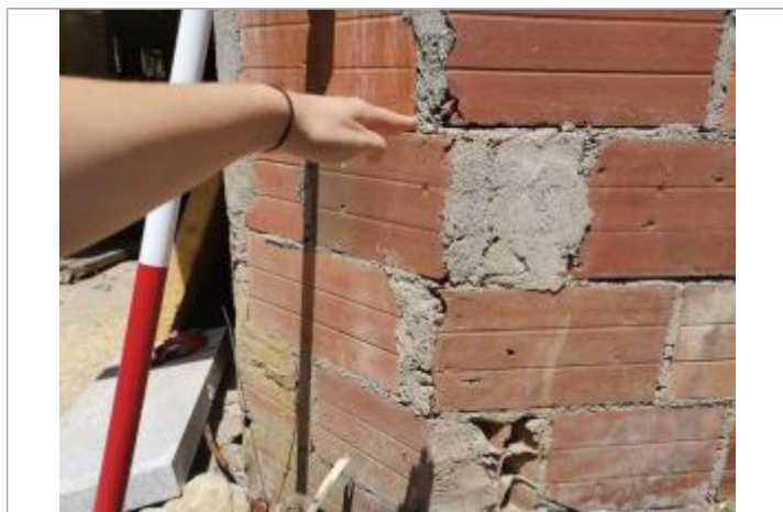
Mur bâtiment - Photo © AGERIN
