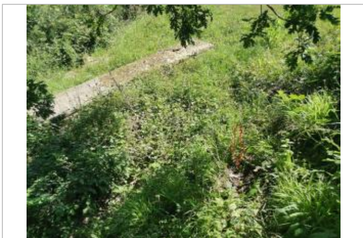
Débris sur le sol - Photo © AGERIN
