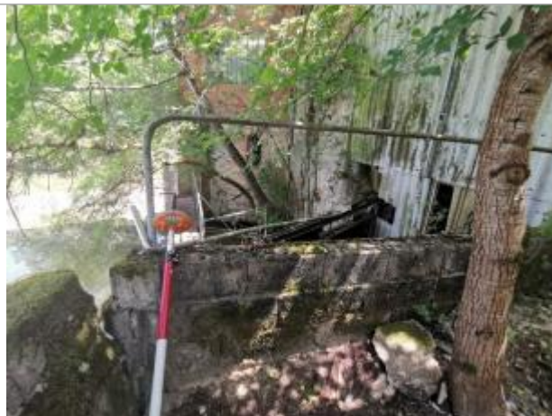
Muret en parpaing - Photo © AGERIN
