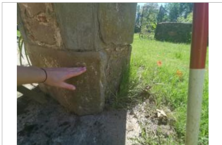
Poteau bâtiment moulin - Photo © AGERIN
