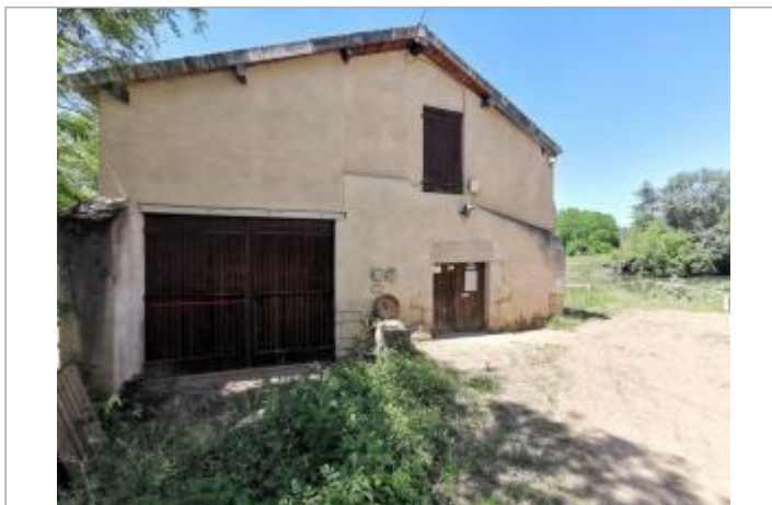
Porte bâtiment - Photo © AGERIN
