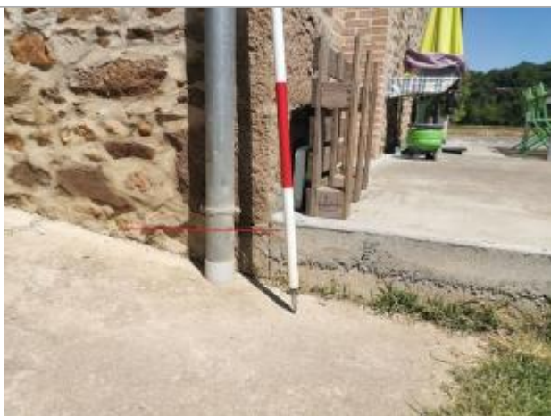
Gouttière maison moulin - Photo © AGERIN
