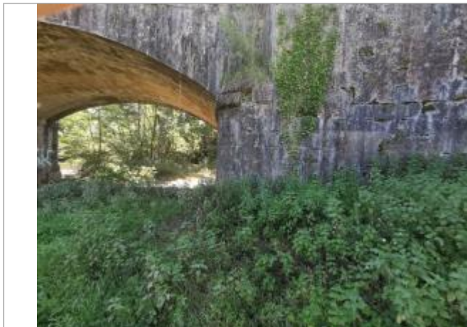
Pont (aval rive gauche) - Photo © AGERIN
