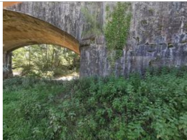
Pont (aval rive gauche) - Photo © AGERIN
