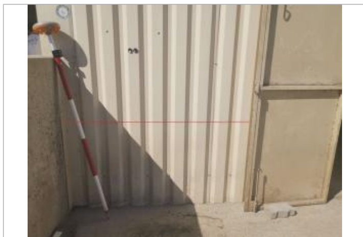
Trace sur le bâtiment - Photo © AGERIN
