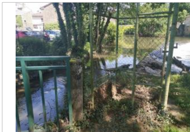
Débris sur le grillage - Photo © AGERIN
