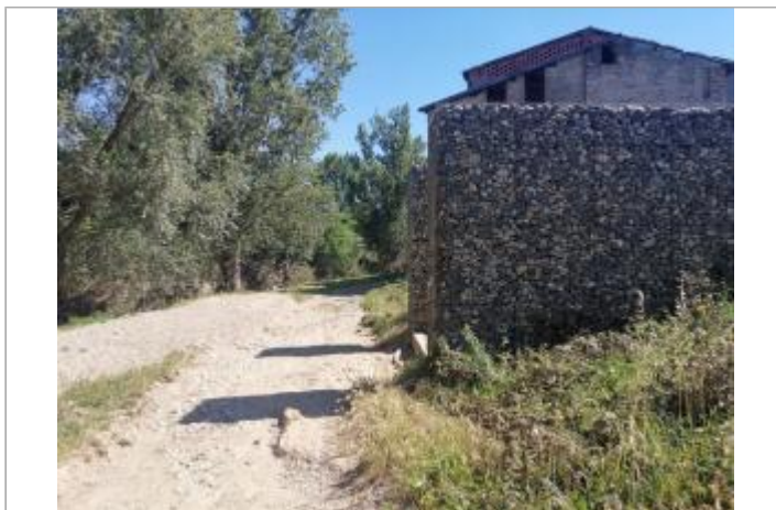
Mur en gabions - Photo © AGERIN
