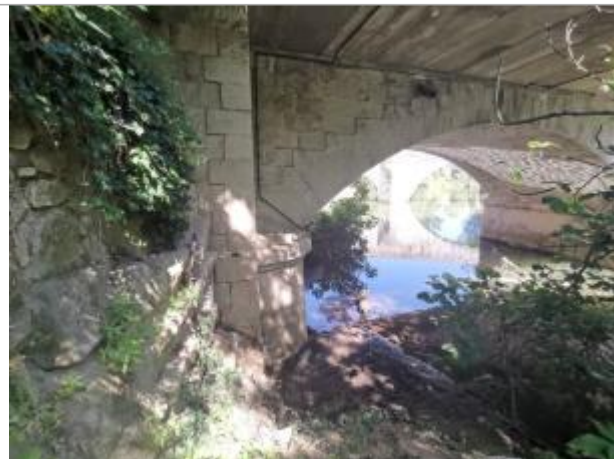
Pont (amont rive gauche) - Photo © AGERIN
