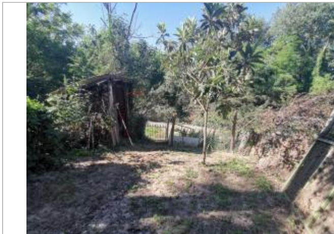
Abri en bois - Photo © AGERIN
