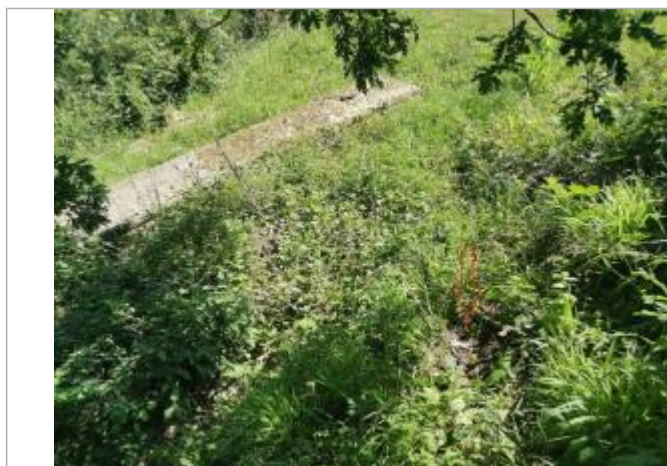
Débris sur le sol - Photo © AGERIN
