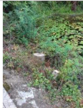
Aval RG du bras de décharge "Fossé neuf"
