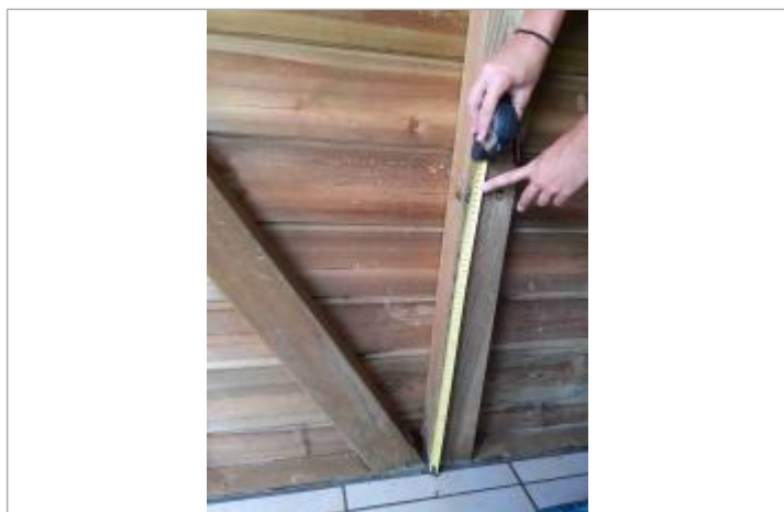
Dépôt matière solide sur mur en bois
