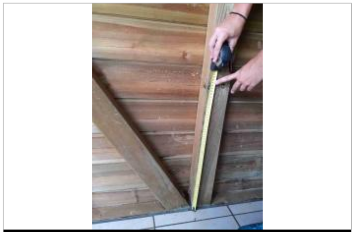
Dépôt matière solide sur mur en bois
