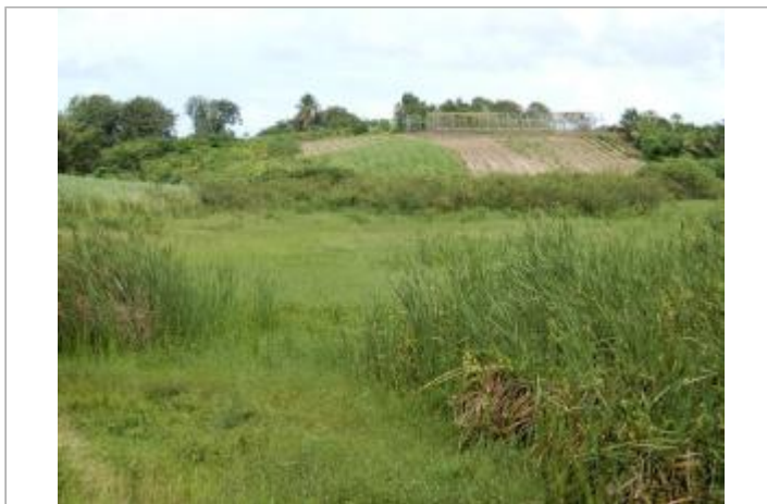
Barrage de Gaschet - zone de stockage
