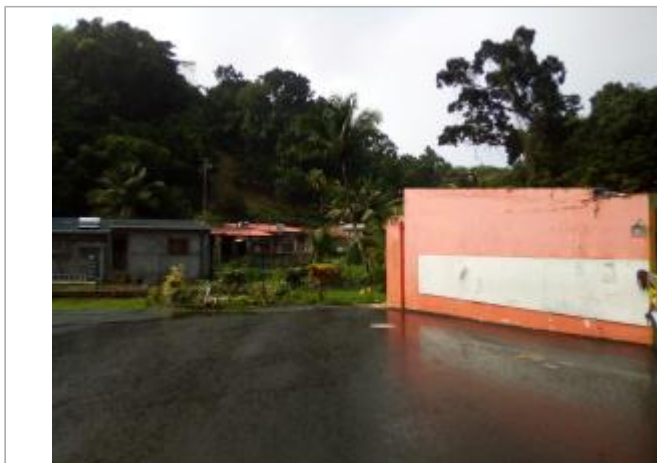
Inondation bâtiment d'école
