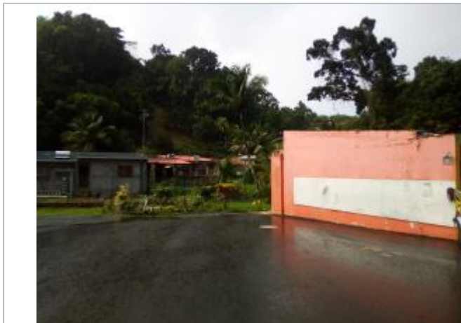
Inondation bâtiment d'école
