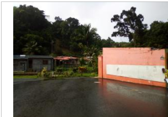
Inondation bâtiment d'école
