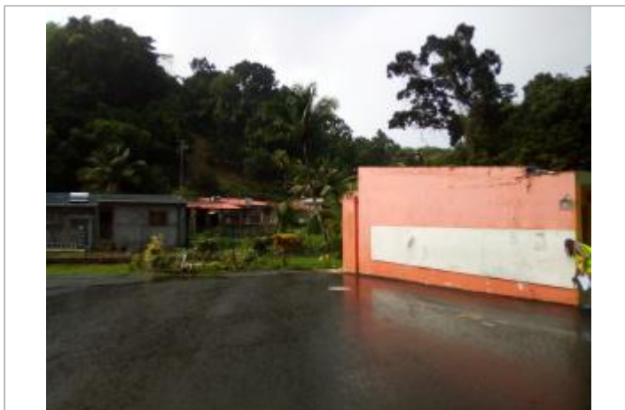
Inondation bâtiment d'école
