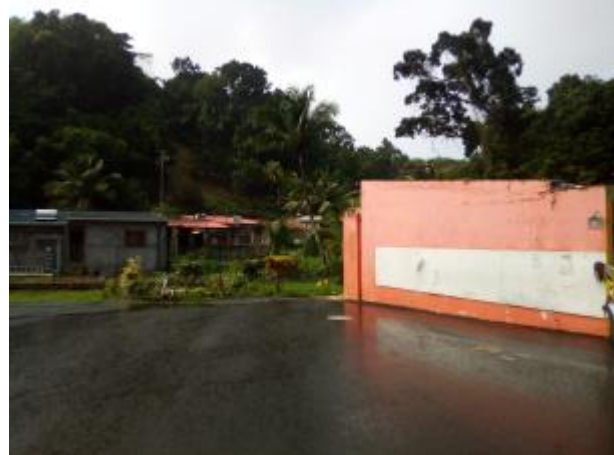
Inondation bâtiment d'école
