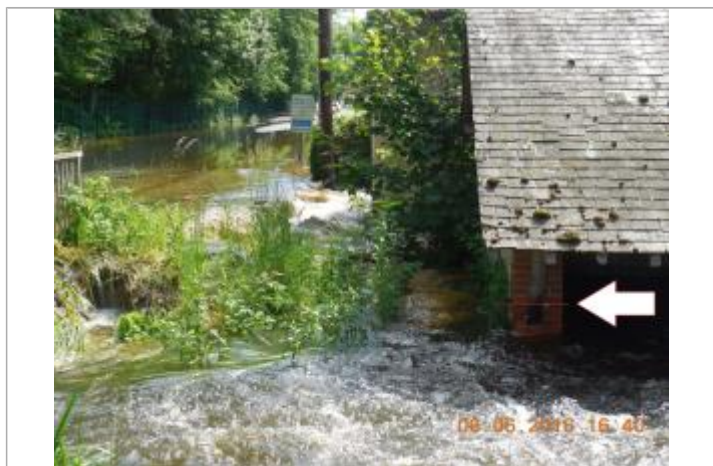
Laisse de la crue de juin 2016
