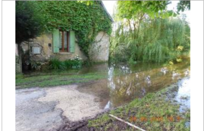
Photographie de la crue de juin 2016
