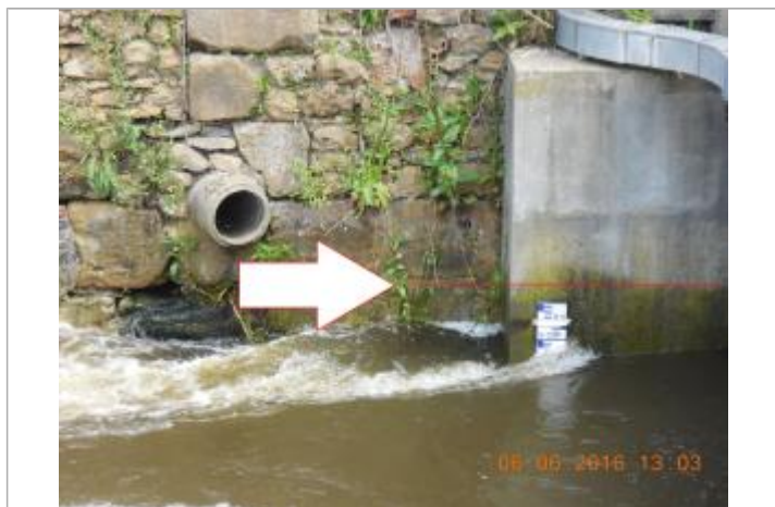
Photographie de la crue de juin 2016
