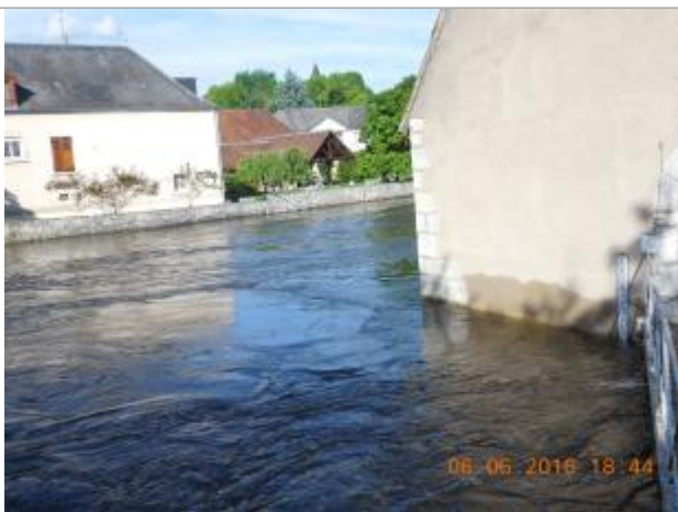
Photographie de la crue de juin 2016
