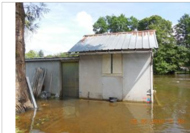
Photographie de la crue de juin 2016
