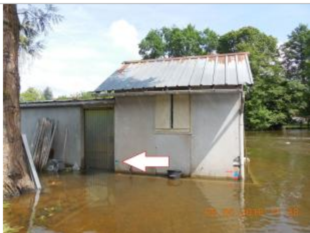
Marque de la crue de juin 2016
