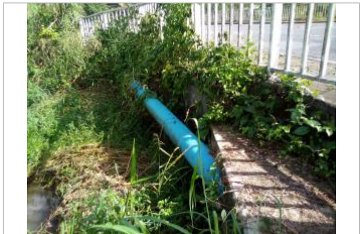
Canal obstrué, végétation dense et couchée
