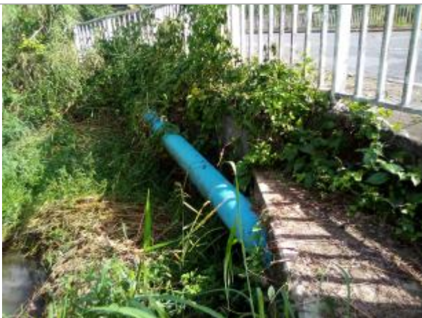
Canal obstrué, végétation dense et couchée
