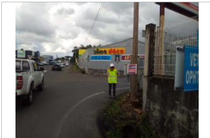
Laisse d'inondation en bordure de ravine
