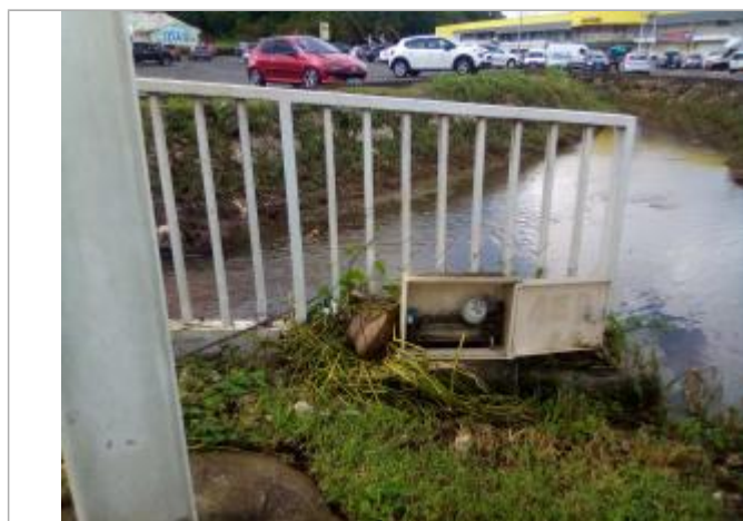
Dépôt de matière solide (branchage, coco)
