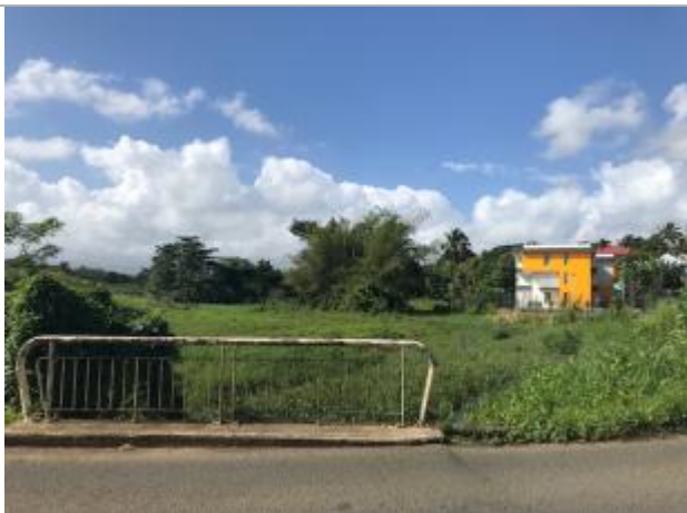
Laisse de crue sur le pont passant au dessus de la rivière La Digue
