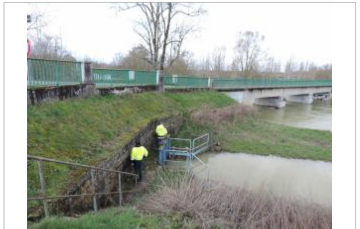
Amont du pont en rive gauche
