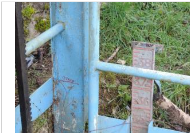
Ouvrage bleu avec échelle en amont du pont, RG
