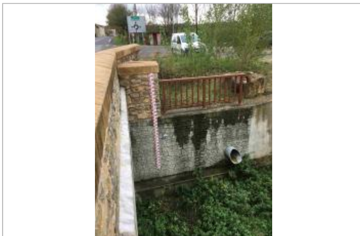
L'Algouse au niveau du pont de la D922 à Farrou
