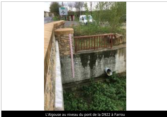
L'Algouse au niveau du pont de la D922 à Farrou
