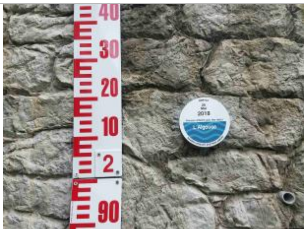
Repère de la crue du 29 mai 2018 sur le pont de la D922 à Farrou
