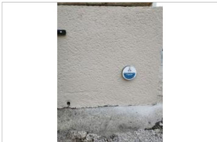
Repère de la crue du 29 mai 2018 au niveau de l'entrée du parking du Relai de Farrou
