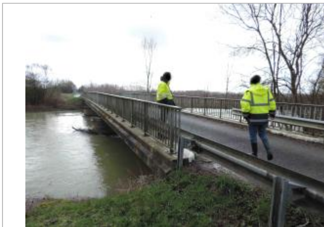
Pont sur la D58
