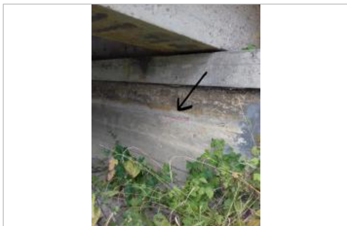
Amont rive droite du pont sur la D58
