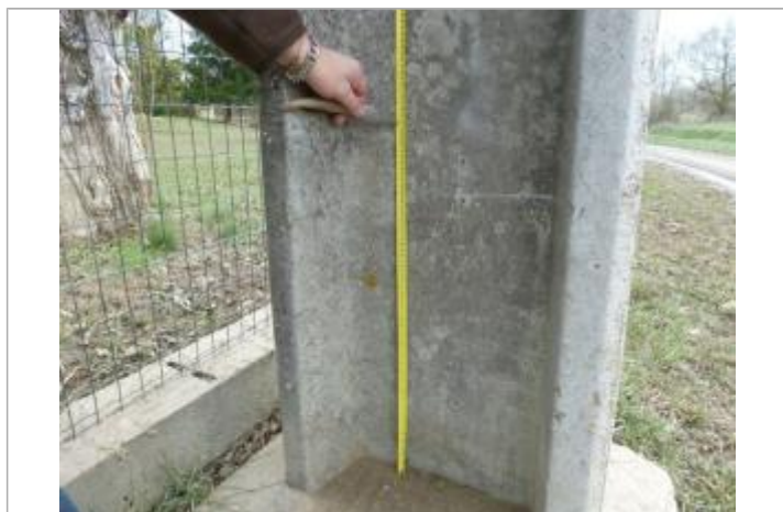
Trace de laisse poteau - Photo ©DDT47
