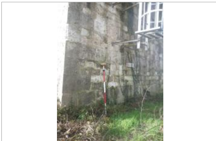
Pont D308 - pile rive gauche - Photo ©AGERIN et DDT47
