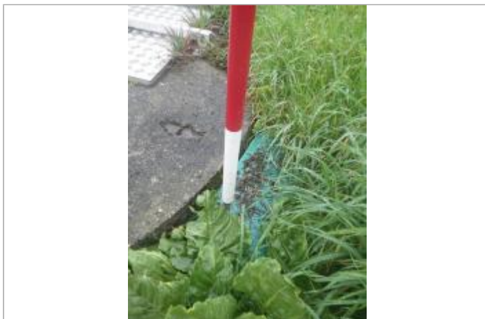
Berge rive droite - Photo ©AGERIN
