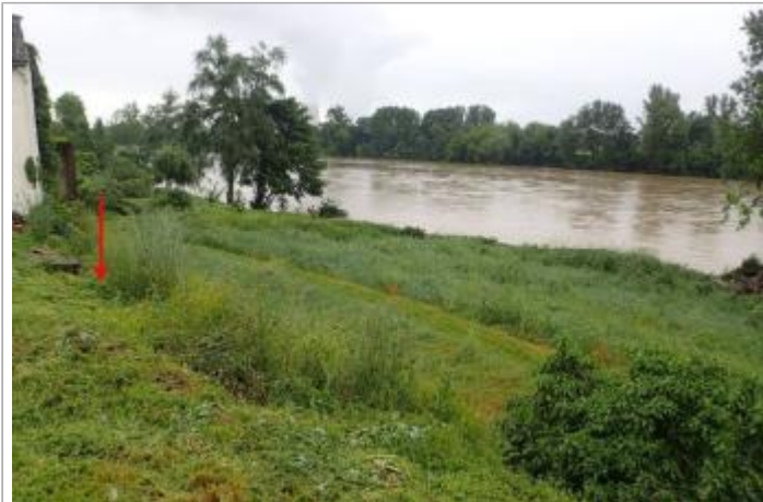
Berge rive droite proche rue Pasteur - Photo ©AGERIN
