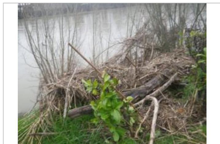
Débris végétaux sur végétation - Photo ©AGERIN
