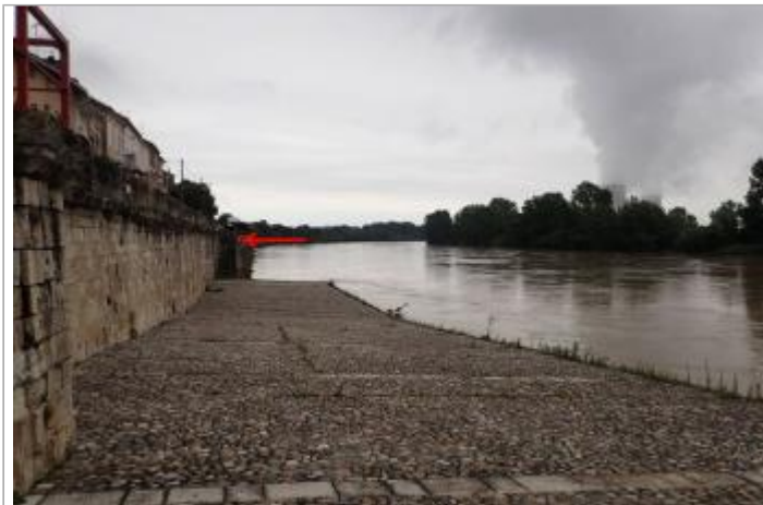
Escaliers quai Chauderon - Photo ©AGERIN
