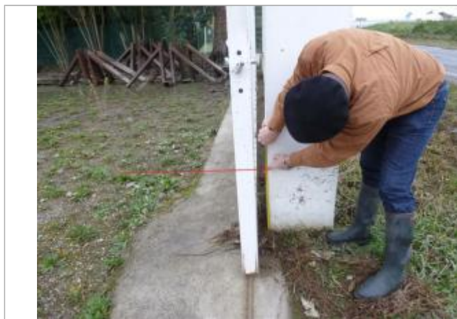
Trace muret portail - Photo ©DDT
