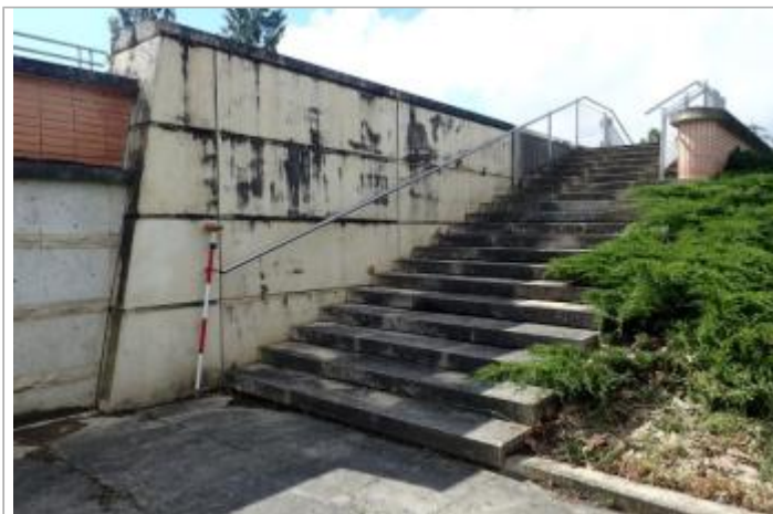
Escalier rive gauche - Photo ©AGERIN
