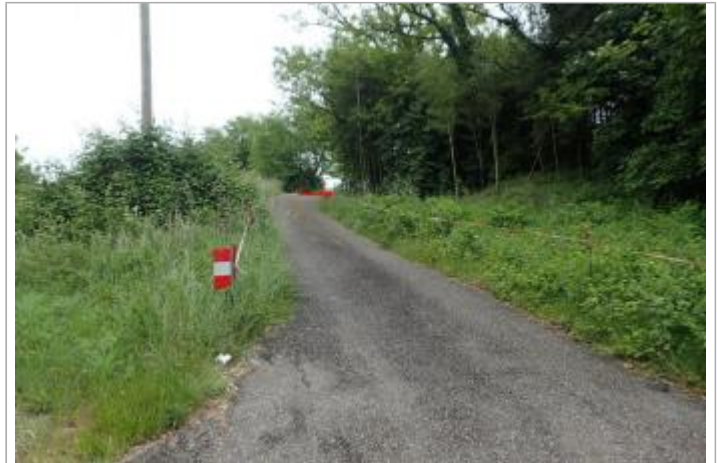
Route en amont du pont de la voie ferrée - Photo ©AGERIN
