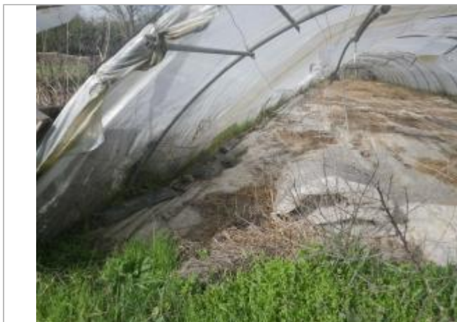
Berge rive droite - Photo ©AGERIN
